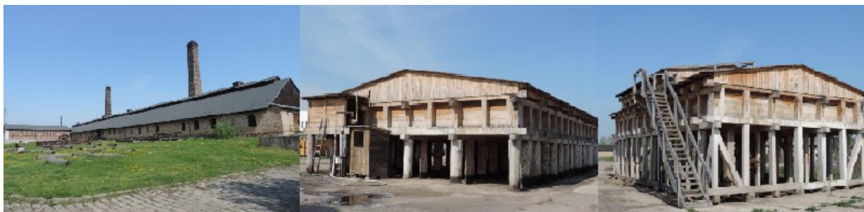
Zdjęcie 3. Warzelnia soli: budynek warzelni, rezerwar nr II, rezerwar nr I
