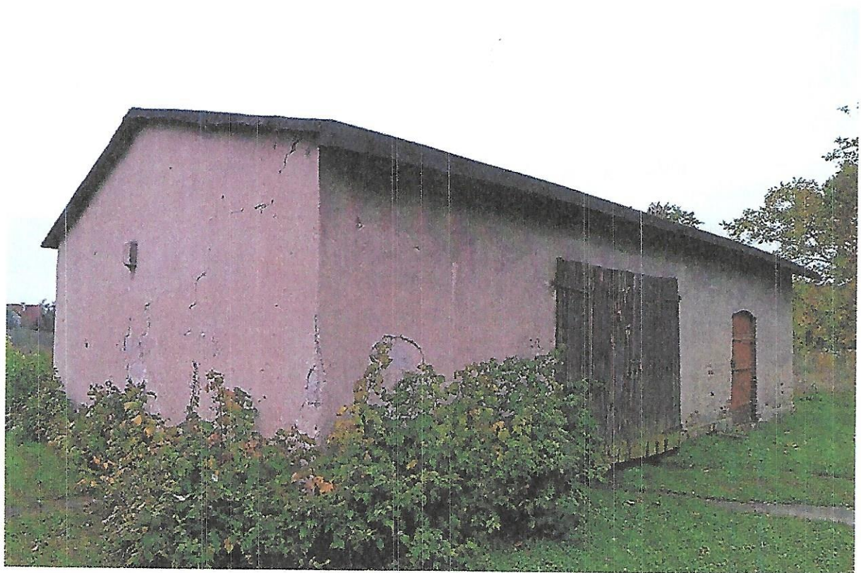
Zdj.6 Budynek gospodarczy nr 1, widok z boku.
