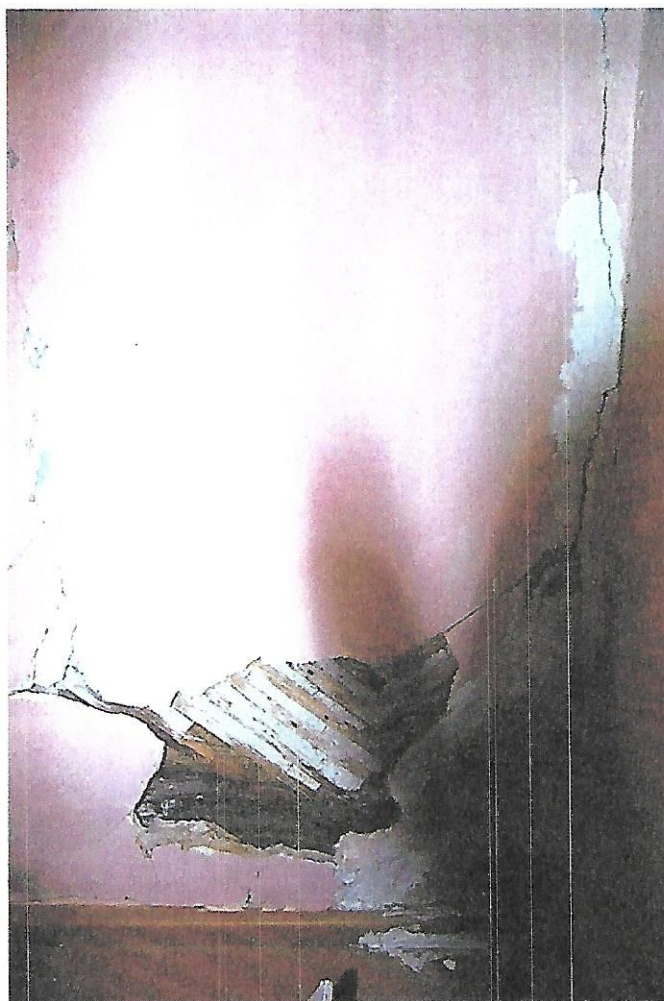
Zdj. 4 Odprysk tynku od ściany
